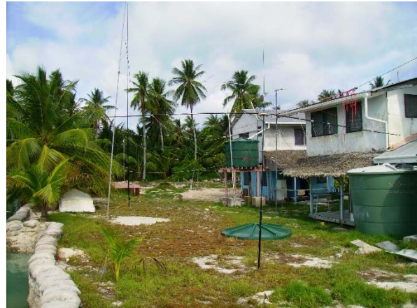
Die Anlage mit einigen Antennen
