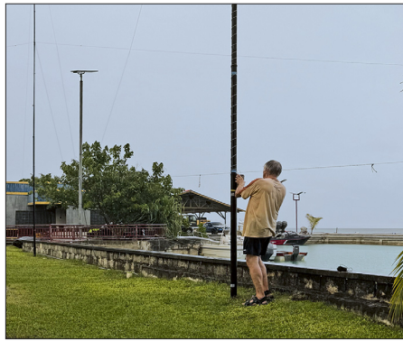
80-m-Full-Size-Vertikal; Rolf montiert die Verlängerungsspule für 160 m.
